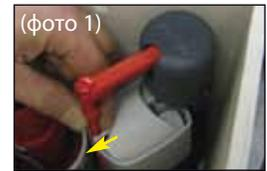
▶ ПРОТЕЧКА ВОДЫ ЧЕРЕЗ ПЕРЕЛИВ КЛАПАНА СЛИВНОГО МЕХАНИЗМА
