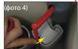
▶ НАПОЛНИТЕЛЬНЫЙ КЛАПАН НЕ ЗАКРЫВАЕТСЯ ИЛИ ЗАКРЫВАЕТСЯ ОЧЕНЬ МЕДЛЕННО (При установке)
